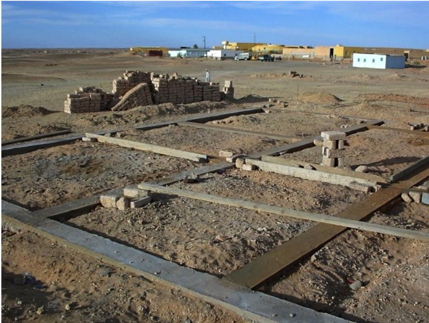
L'orizzontalità e la solidità della fondazione, ovvero un valido attacco a terra, sono state elementi decisivi per la resistenza all'alluvione dell'intera costruzione.
