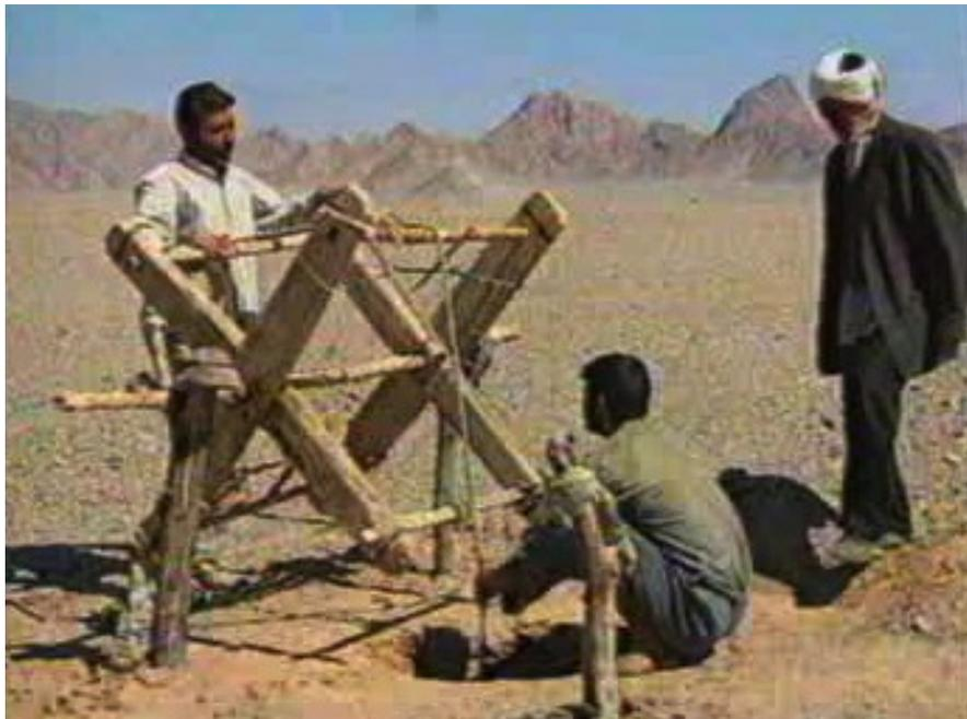
Questa tecnica presenta infiniti pericoli e i risultati si ottengono allineando i pozzi in successione, guardando torce nel percorso già completato.
